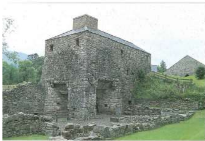
Fig. 8.43 Complesso produttivo incentrato sull'altoforno a carbone di legna di Durban (Scozia Meridionale). Si notino i resti delle strutture circostanti il forno e sulla destra il magazzino. Si osservi l'analogia di questa struttura con quella mostrata nella figura 8.41.
